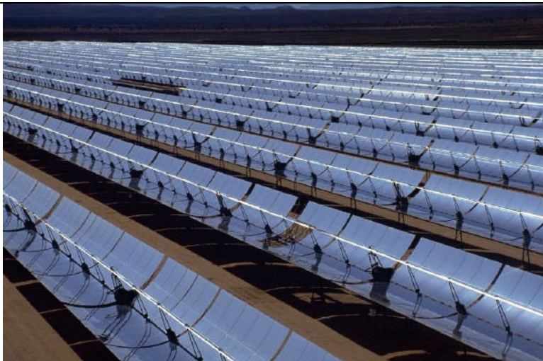
Centrali diellor termal i energjisë elektrike (shndërrimi i nxehtësisë në energji elektrike)
